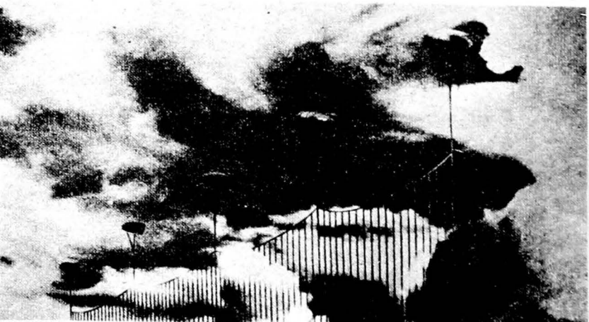
MEDIDAS DE DEFENSA ACTIVA. —El arma principal de los defensores en caso de ataque serán, probablemente, los aeroplanos; pero los cañones antiaéreos no han sido olvidados, y hasta se han construido redes gigantesca sostenidas por globos en el aire.
